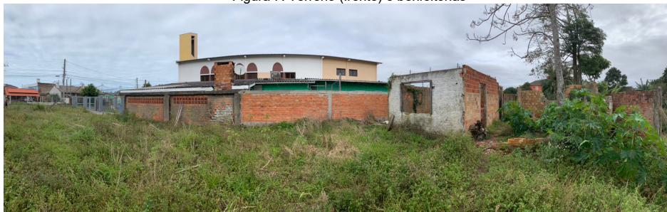
Figura 7: Terreno (frente) e benfeitorias
