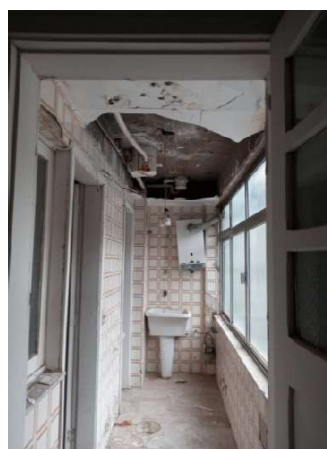
Figura 6: Área de Serviço
