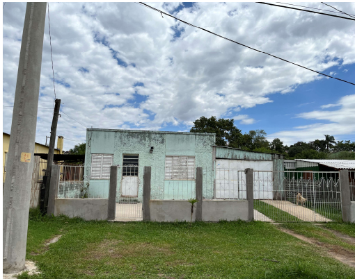
Figura 1- Fachada do imóvel
