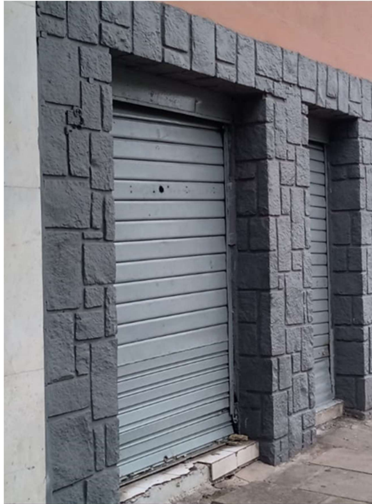
Figura 3: Vista acesso Loja nº7
