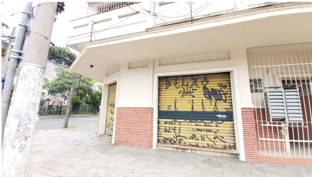
Figura 2: vista externa esquina av. Bento Gonçalves com rua Guilherme Schell
