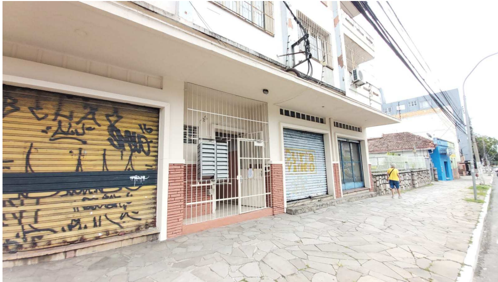
Figura 1: vista externa av. Bento Gonçalves
