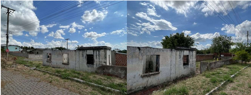
Fachada Rua da Olaria
