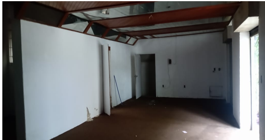
Figura 3: Vista Interior (Fonte: vistoria 19/12/2023)
