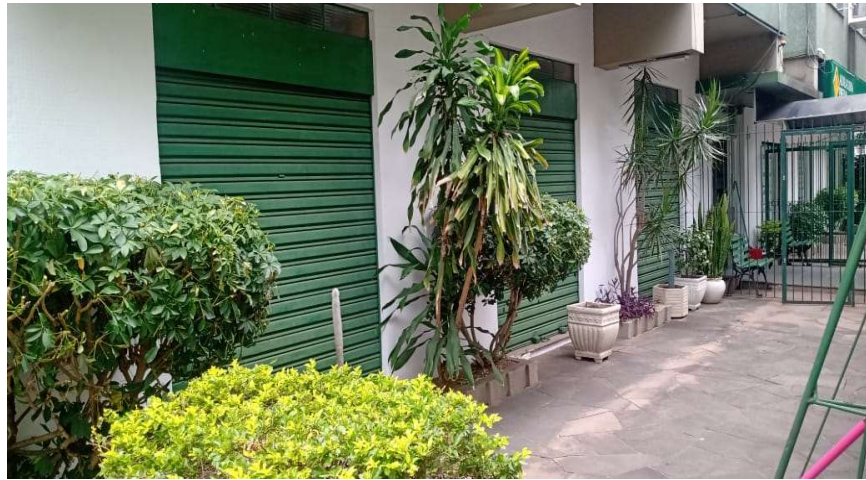
Figura 2: Vista externa (Fonte: Vistoria 19/12/2023)
