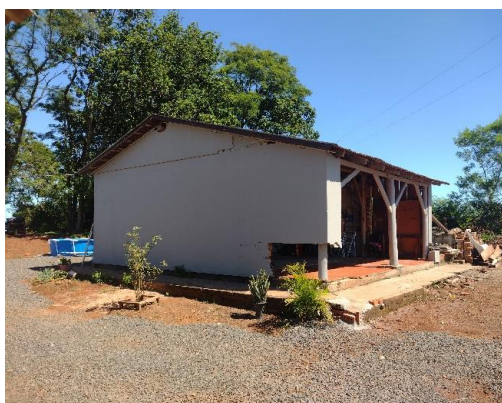
Figura 14: Vista geral da edificação da extinta escola.
