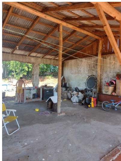
Figura 16: Vista interna do telheiro, feito sobre as ruínas da extinta escola
