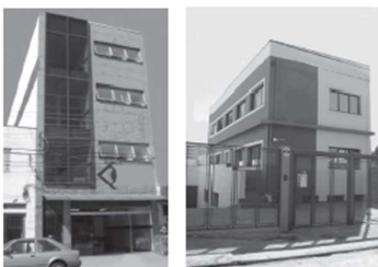
Quadro 1 – Estado de Conservação – Ec
