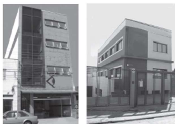
Quadro 1 – Estado de Conservação – Ec
