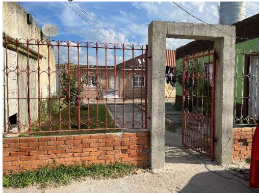
Figura 1: Acesso à rua interna
