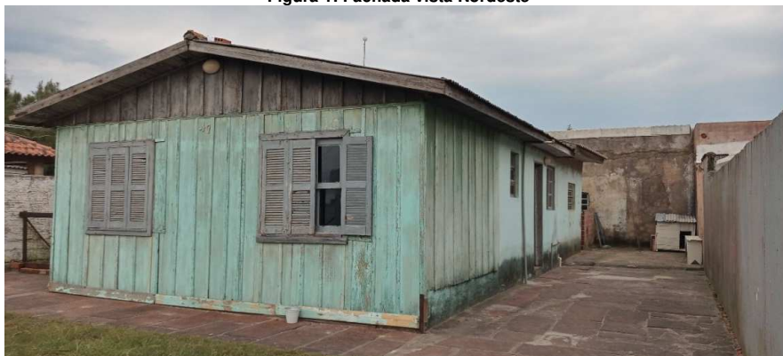
Figura 1: Fachada vista Nordeste
