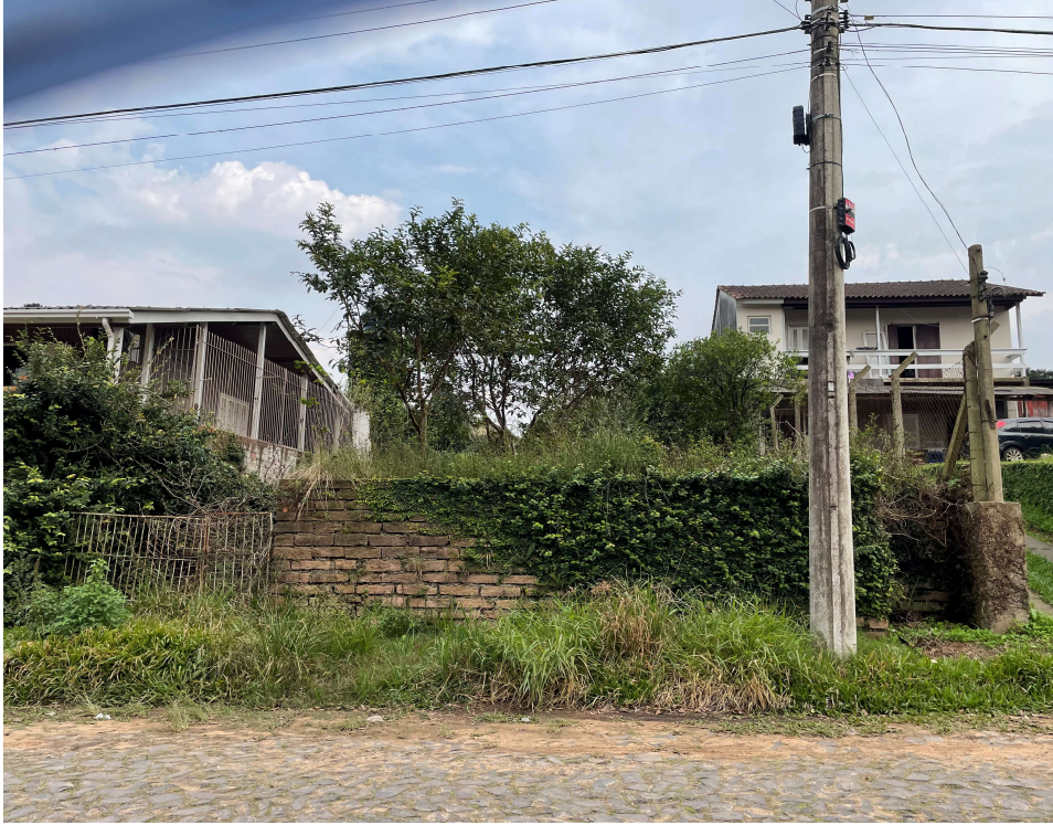
Figura 1: Vista externa prédio geral
