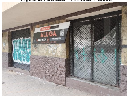
Figura 2: Fachada – Av. João Pessoa
