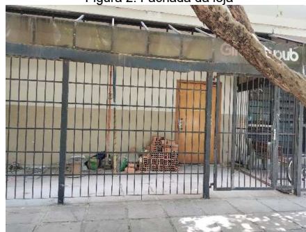
Figura 2: Fachada da loja
