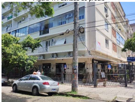
Figura 1: Fachada do prédio
