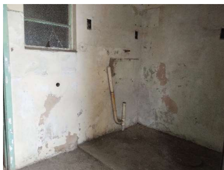
Figura 7: Área de serviço
