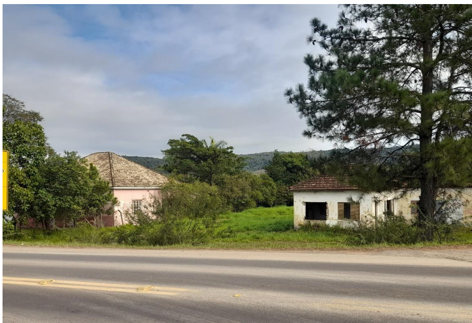
Figura 3: Frente do imóvel
