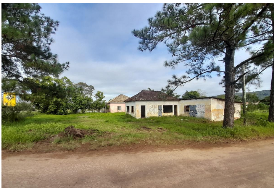
Figura 4: Frente do imóvel
