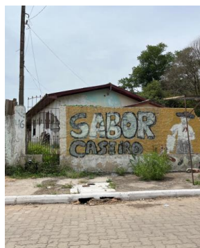
Figura 4: Frente do imóvel
